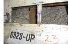
> 매설판 및 관통부 보강재 하부
