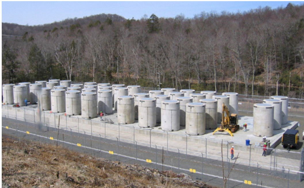
그림 22. (상)스위스 Zwiilag 사용후핵연료 중간저장시설(스위스 원자력 발전 회사들이 공동으로 운영) (하)미국 Connecticut Yankee 원전 사용후핵연료 임시저장 부지
